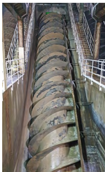
Eine eindruckliche Maschine, genannt Archimedes-Schnecke, sorgt für sauberes Wasser (linkes Bild). Die Teilnehmenden hören dem Referenten gebannt und mit Interesse zu (rechtes Bild). Fotos: Wereliwer?
